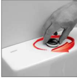
14 Basma butonunun montajı yapılır.
