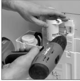
11 Tank ile birleştirilmiş braket bitmiş duvara sabitlenir.
