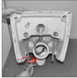
5 Allen anahtarı (5) sarı renkli borunun içerisinden geçirilip setskur gevşettir.
