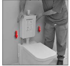
3 Montaj ölçülerini belirlemek için Tank klozetin üzerine yerleştirilir.
