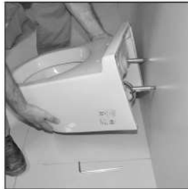
8 Klozet, duvardaki çelik parçalara (4) oturtulur. Çelik parçalar üzerindeki özel oyuklar, aşağıya dönük olmalıdır.
