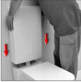
13 Rezervuar Braketin üst kısmındaki tırnaklara oturtulur.
